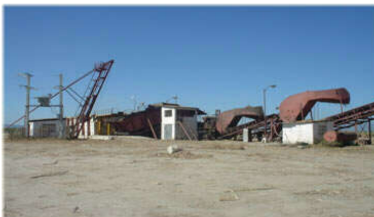
Fig. 1. Algunas instalaciones de interés en el estudio.
