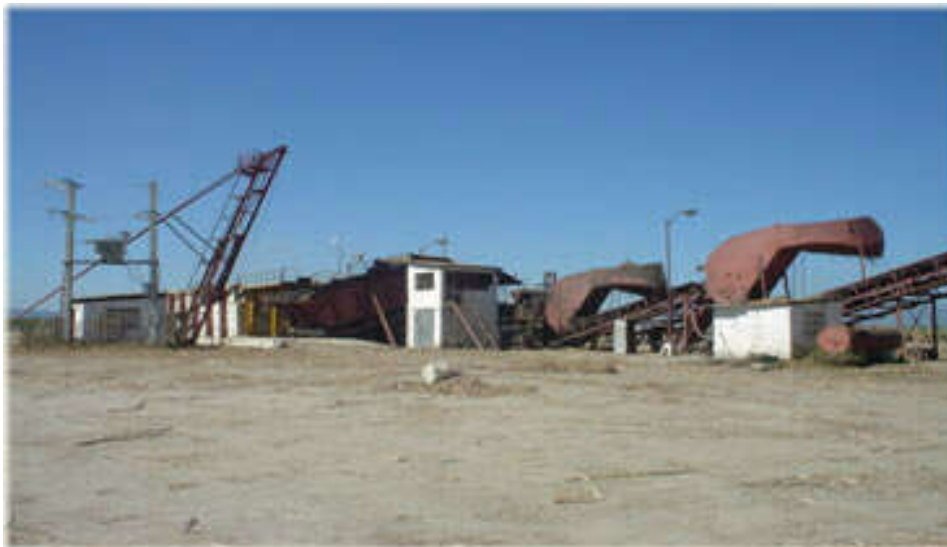
Fig. 2. Instalación de limpieza con tres expansores.
