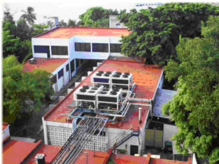
*Fig. 1. Sistema de climatización centralizado por agua helada del Hotel Jagua.*
