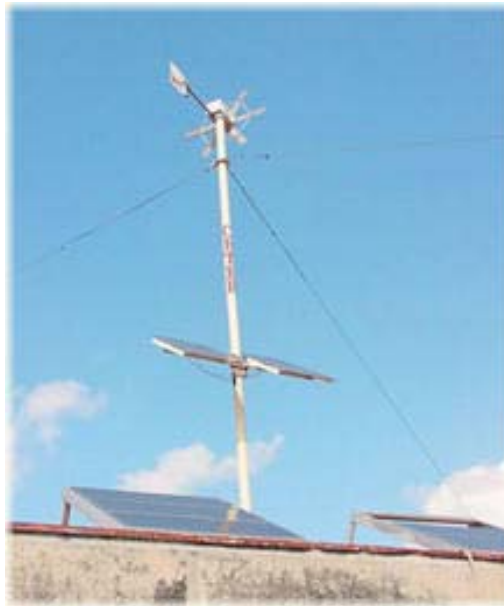
Fig. 1. Sistema híbrido eólico-fotovoltaico con fines docentes, instalado en el Centro de Estudio de Tecnologías Energéticas Renovables (CETER).
