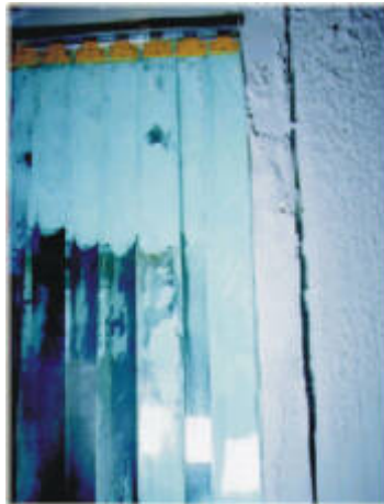
Fig. 3. Puertas y paredes de una cámara de refrigeración.
