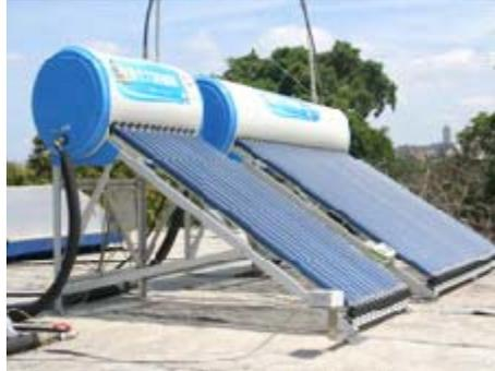
*Fig1. Calentador solar.*
