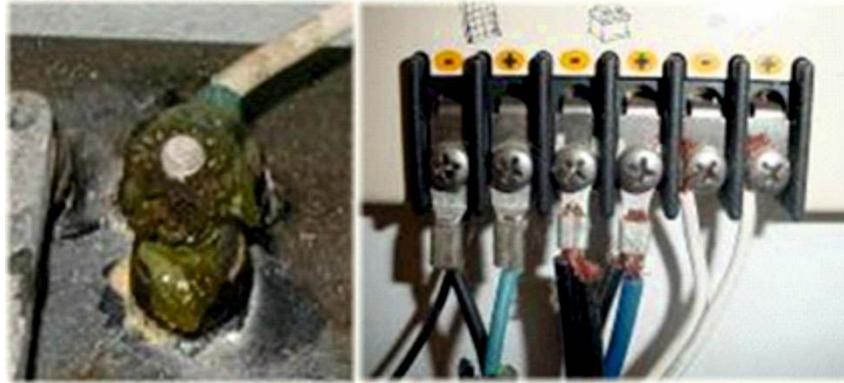
*Fig. 3. Conexión eléctrica y efectos de corrosión*
