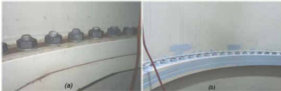
Fig. 3. Efectividad del sistema de protección empleado en una de las uniones en el interior de las torres, a) antes de la rehabilitación, b) después de la rehabilitación.
