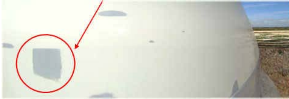
Fig. 1. Zonas rehabilitadas por corrosión en una de las torres.
