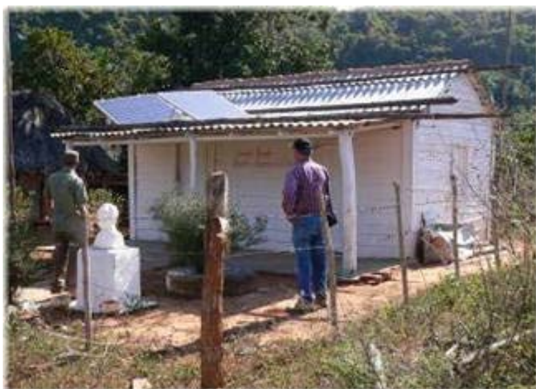
Fig. 12. Escuela con sistema fotovoltaico autónomo.
