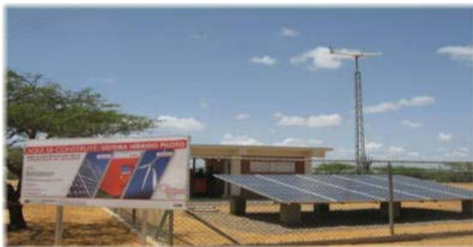
Fig. 34. Sistemas híbridos eólico-fotovoltaico-diésel.
