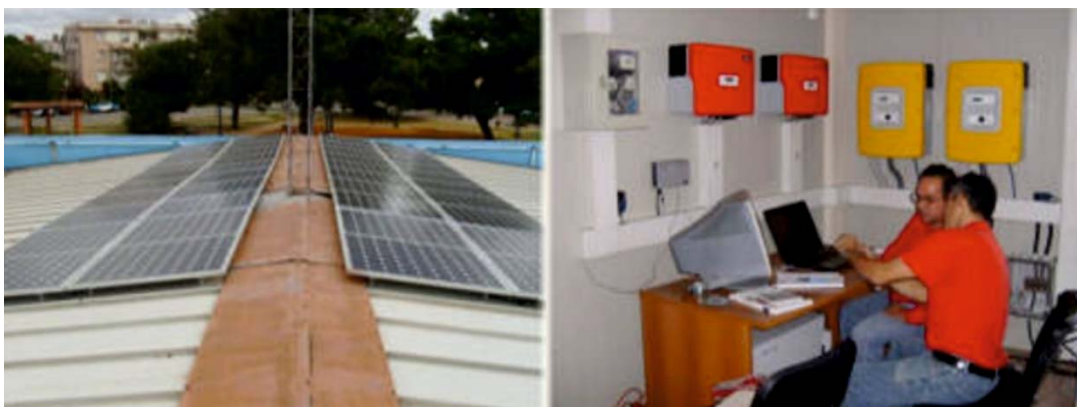
Figs. 26-27. Instalación de módulos fotovoltaicos en EcoSol Energía.
