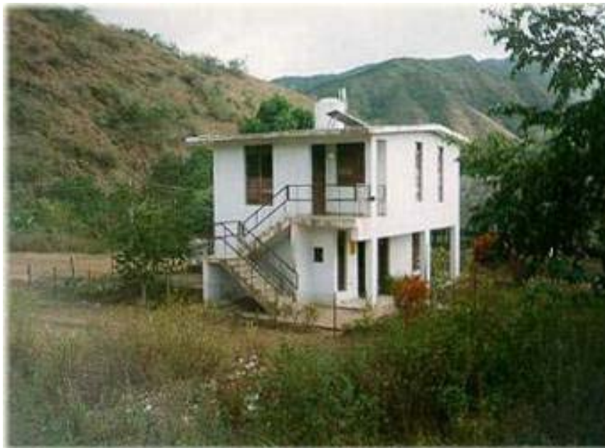
Fig. 10. Consultorio médico con sistema fotovoltaico autónomo.
