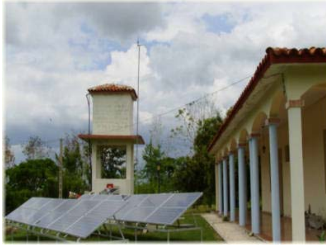
Fig. 25. Instalación por EcoSol Energía de su primer sistema de conexión a red, municipio de Bartolomé Masó, provincia Granma.
