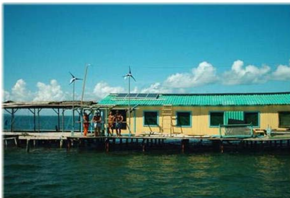
Fig. 16. Instalación con sistema híbrido fotovoltaico-eólico.
