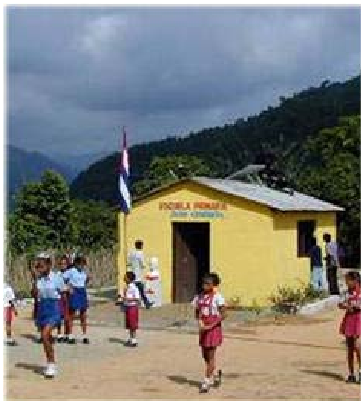
Fig. 13. Escuela con sistema fotovoltaico autónomo.
