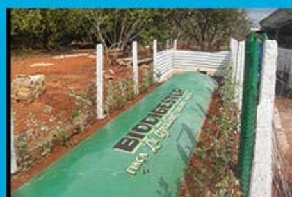
Biodigestores familiares del tipo "GBV" construídos con la acción participativa de los usuarios. Diseño "Kmaleón"
