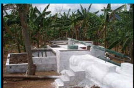
Biodigestores familiares del tipo "GBV" construídos con la acción participativa de los usuarios. Diseño "Kmaleón"
