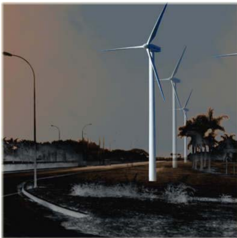
Fig. 21. Aerogenerador tripala terrestre.
