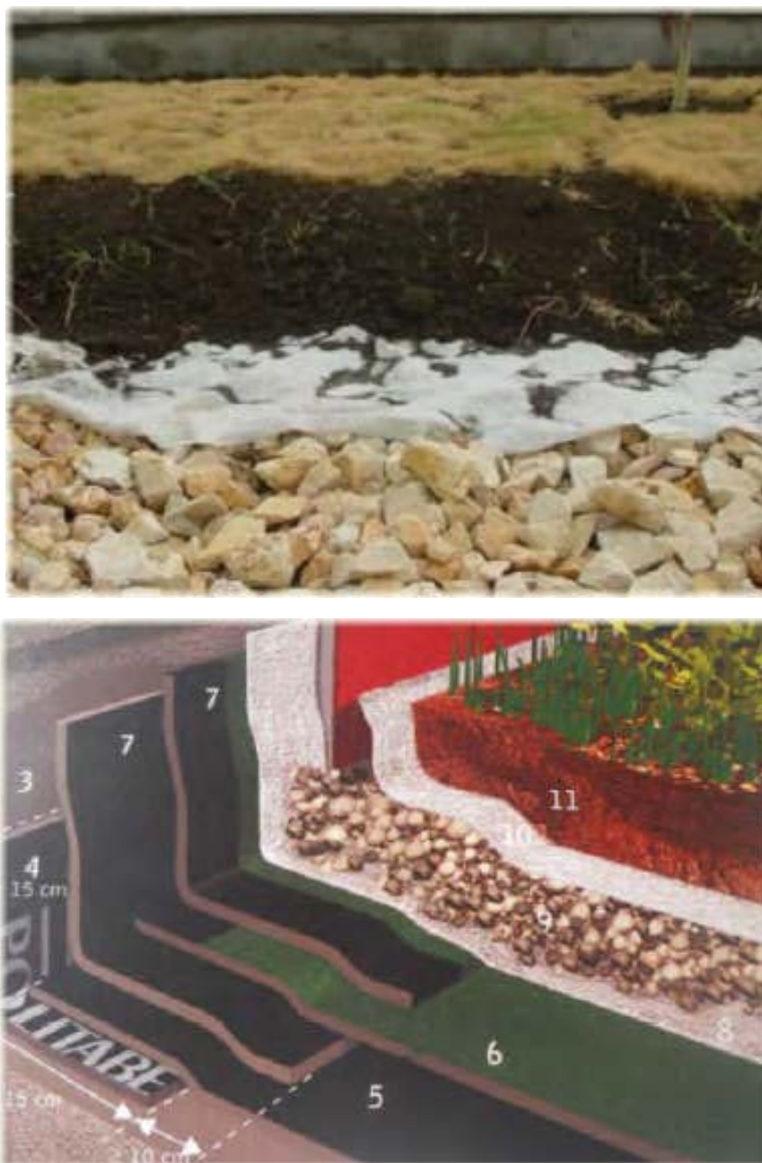
Fig. 12. Detalle jardín de la cubierta del FOCSA. Solución técnica a partir del uso de láminas asfálticas.
