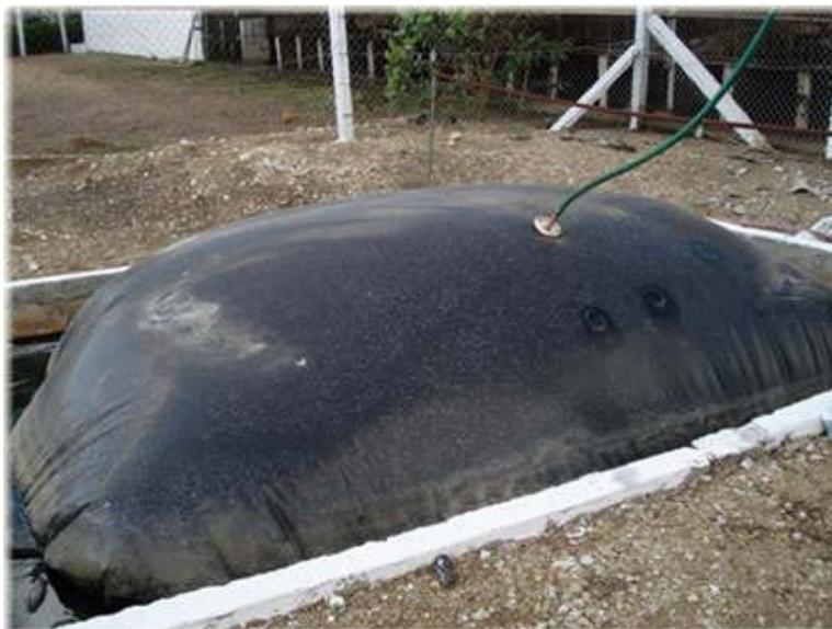
*Fig. 2. Biodigestores tipo túneles.*
