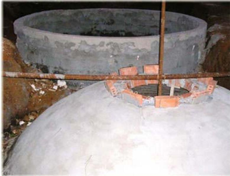
*Fig. 1. Biodigestores de cúpula fija.*
