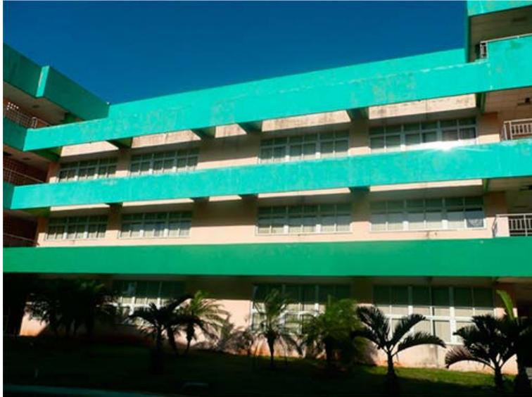
*Fig. 16. Elementos de protección solar existentes en el edificio 3.*
