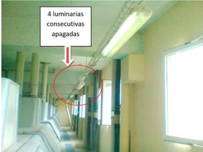
Fig. 3. Sistema de iluminación actual mostrando deficiencias por lámparas falladas. (Fotografía cortesía de los autores).
