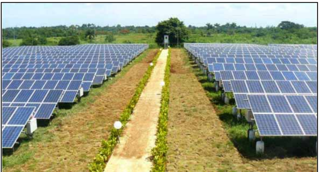
Fig. 12. Parques fotovoltaicos: 1 kW genera 1500 kWh anuales.
