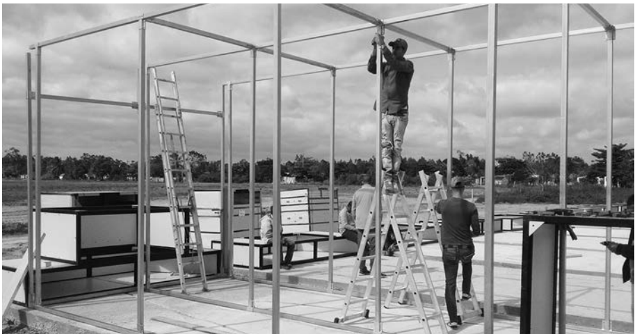
Fig. 1. Proceso de construcción.
