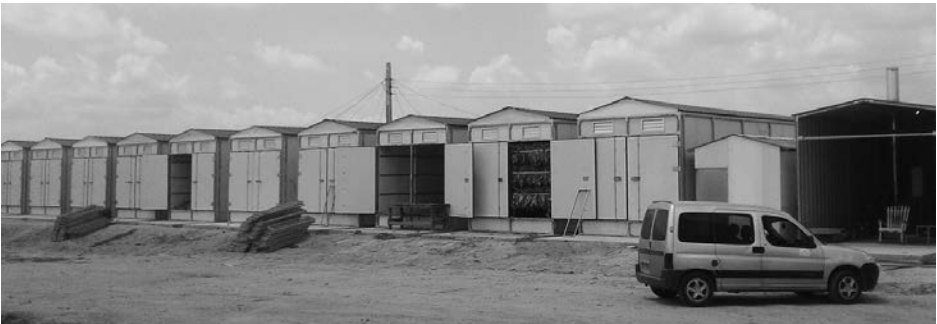
Fig. 4. Batería de cámaras.
