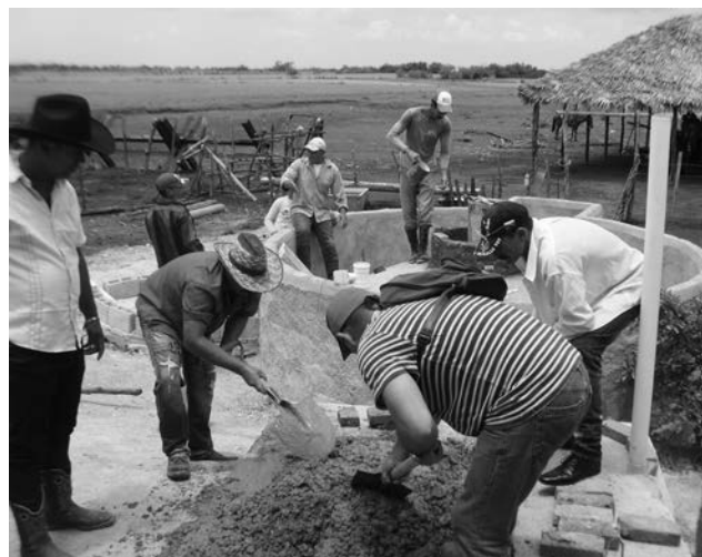
Fig. 2. Construcción del biodigestor.
