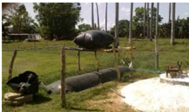
Fig. 2. Biodigestor y esquema de distribución de los residuales. Fuente: Autor y Eco-Source Solutions.
