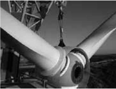
Fig. 5. Cambio de rotor.
