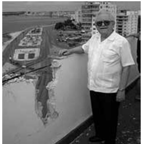
Fig. 1. Destrozo producido el 25 de junio de 2009 por un rayo en la azotea del edificio aludido en el texto, con la entrada a la bahía de La Habana al fondo y el autor captado junto al boquete.
