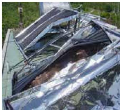
b) Destrucción de calentador solar sobre cubierta.
