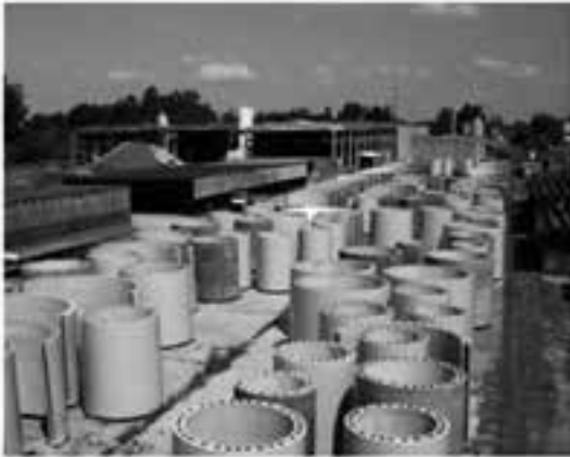
Fig. 3. Fabricación de torres de hormigón.
