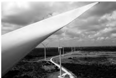
Fig. 4. Parque eólico del Centro de Energía Eólica HorseHollow.
