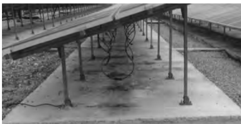
Fig. 6. Tableta de losa de hormigón.
