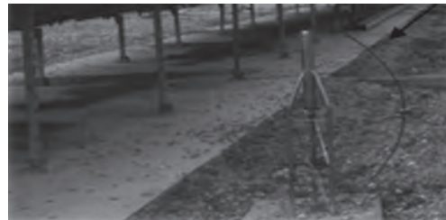
Fig. 1. Aterramiento inadecuado.
