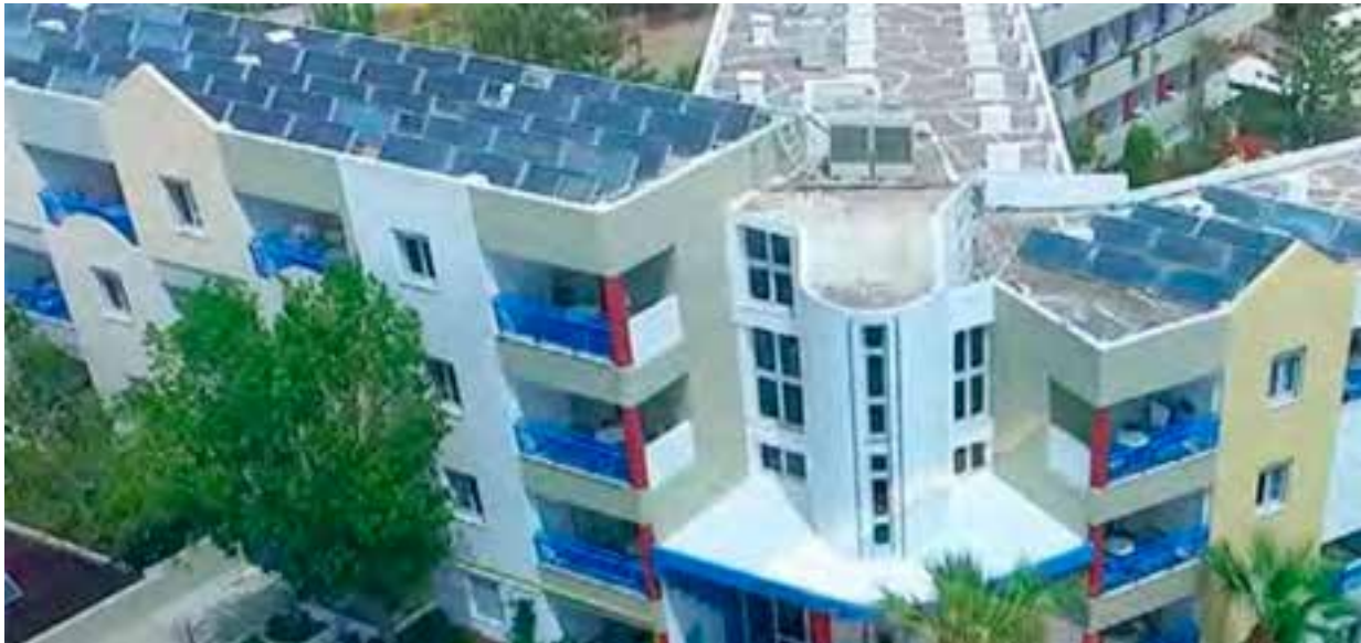
Fig. 4. Hotel Ibscos Garden Blue Star, Grecia. Hotel de ciudad con 324 camas que cubre 50 % de su energía mediante FRE (solar fotovoltaica y térmica)
