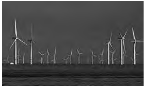
Fig. 7. Parque eólico Gwynt y Mor, ubicado a más de 12 km de la bahía de Liverpool.
