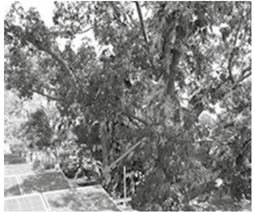
Fig. 3. Sombra sobre los módulos fotovoltaicos.
