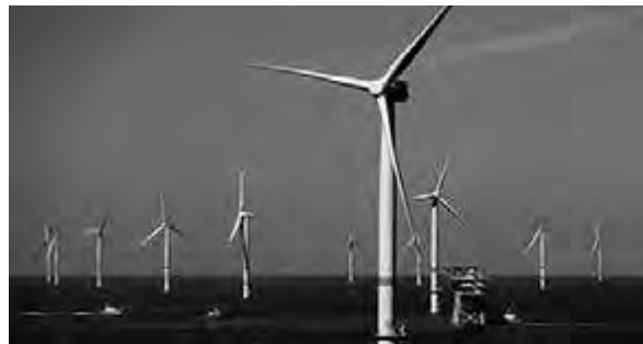
Fig. 5. El parque eólico marino más potente del mundo: Walney Extension, de 659 MW de potencia instalada.
