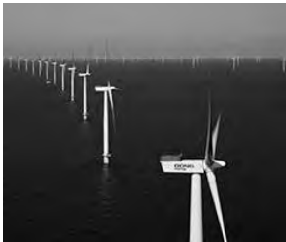
Fig. 9. Parque eólico Anholt, con una potencia instalada de 400 MW, en Dinamarca.
