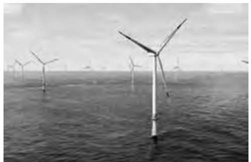
Fig. 2. Parque eólico Hornsea One (en construcción).
