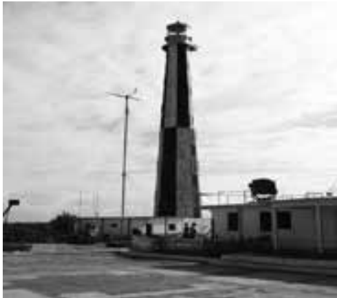
Fig. 4. Ejemplo de aplicación de un pequeño aerogenerador en una zona de seguridad en un faro.
