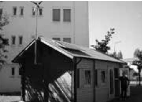
Fig. 7. Ejemplo de aplicación de un pequeño aerogenerador en un aula docente.
