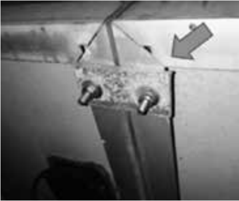
Fig. 4. Placas atornilladas.
