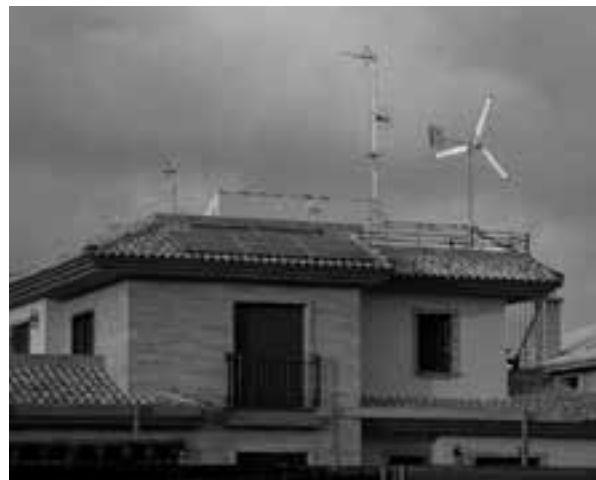
Fig. 1. Ejemplo de pequeño aerogenerador en uso residencial.
