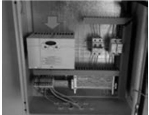
Fig. 6. Inversor cargador de batería.
