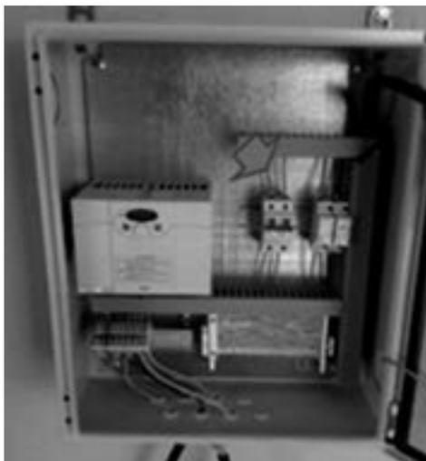
Fig. 5. Desconectivo de la bomba sumergible.
