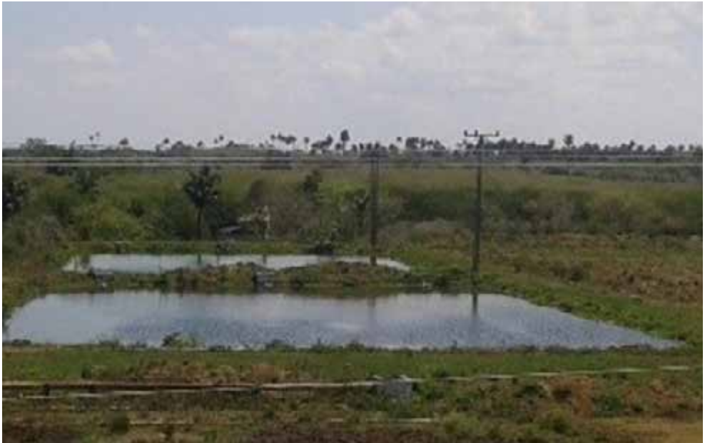
Fig. 4. Laguna de oxidación.
