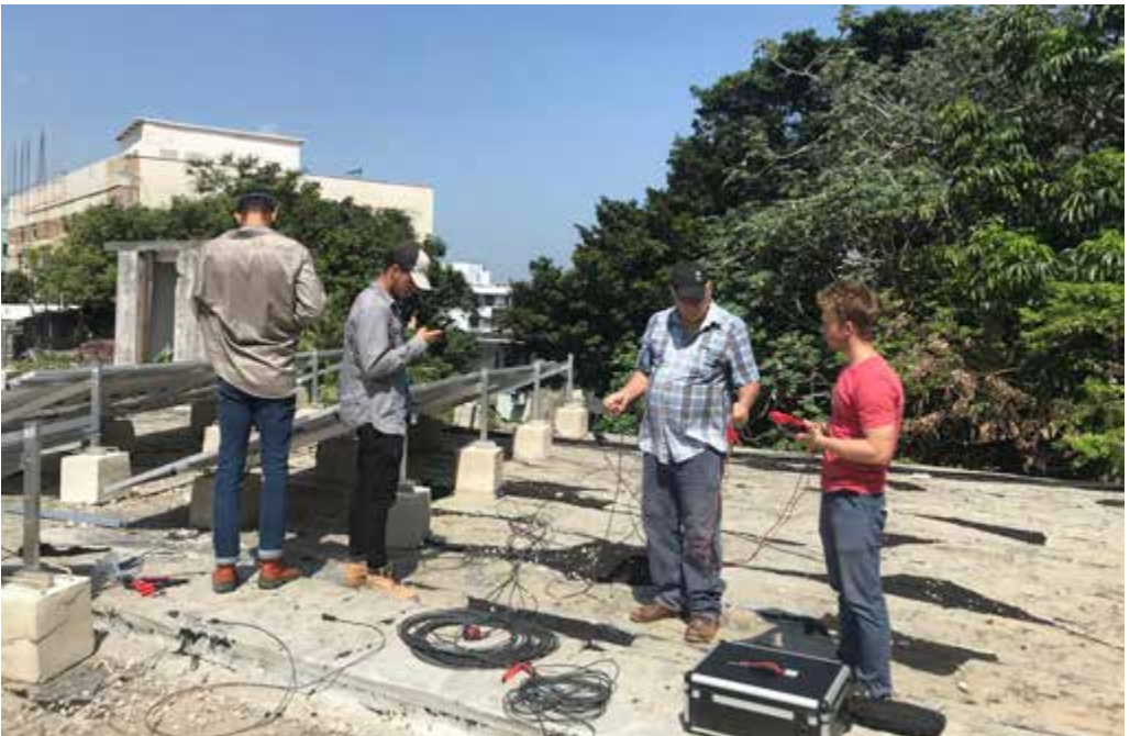
Montaje de un sistema fotovoltaico en el polígono de Cubaenergía.
