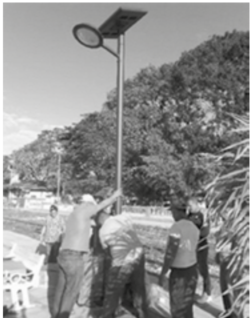
Instalación de luminaria pública FV, municipio Florencia, Ciego de Ávila.
