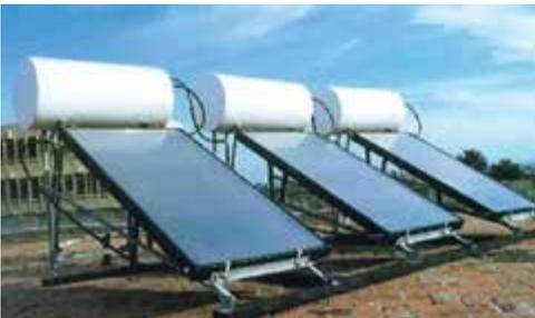
Sistema termosifónico con colectores solares planos.
