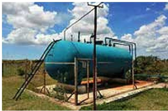
Fig. 3. Depósito del biogás.
