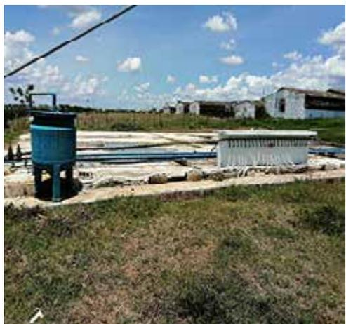
Fig. 2. Biodigestor de cubierta plana.
