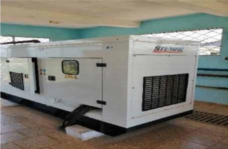
Fig. 9. Grupo electrógeno a biogás.
