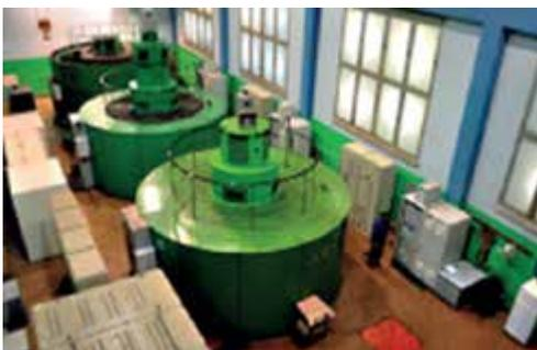
Turbinas hidráulicas de una PCHÉ.
