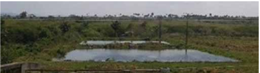
Fig. 3. Lagunas de oxidación.
