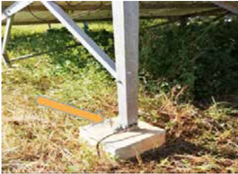
Fig. 6. Aterramiento de la instalación solar fotovoltaica.
