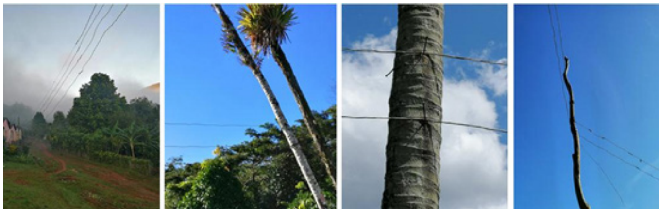
Fig. 2. Estado de las redes de suministro y formas de emplazamiento en el terreno (Labrada et al. , 2021).
