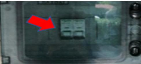
Fig. 6. Interruptor magnetotérmico.
