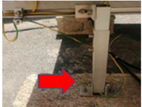
Fig. 3. Aterramiento de la estructura de los módulos solares fotovoltaicos.
