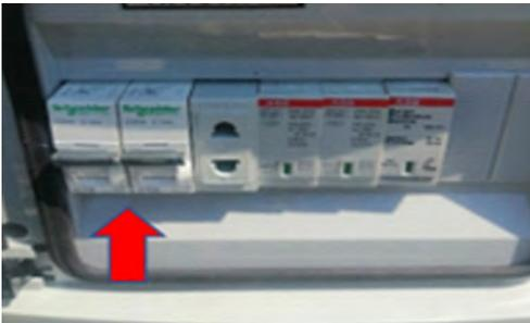
Fig. 5. Interruptores magnetotérmicos.
