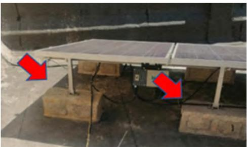
Fig. 7. Bloque macizado con hormigón.
