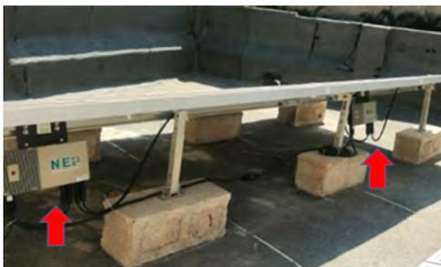
Fig. 2. Interconexión de los módulos solares fotovoltaicos a los microinversores.
